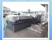
外壁のハツリ排水を凝集剤を 使用し処理し、その後、下水 道へ排出。
